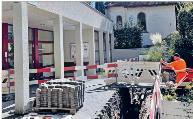
Verlegung der Fernwärmeleitung für die Gebäude der Pfarrei. Foto: Armin Huber
