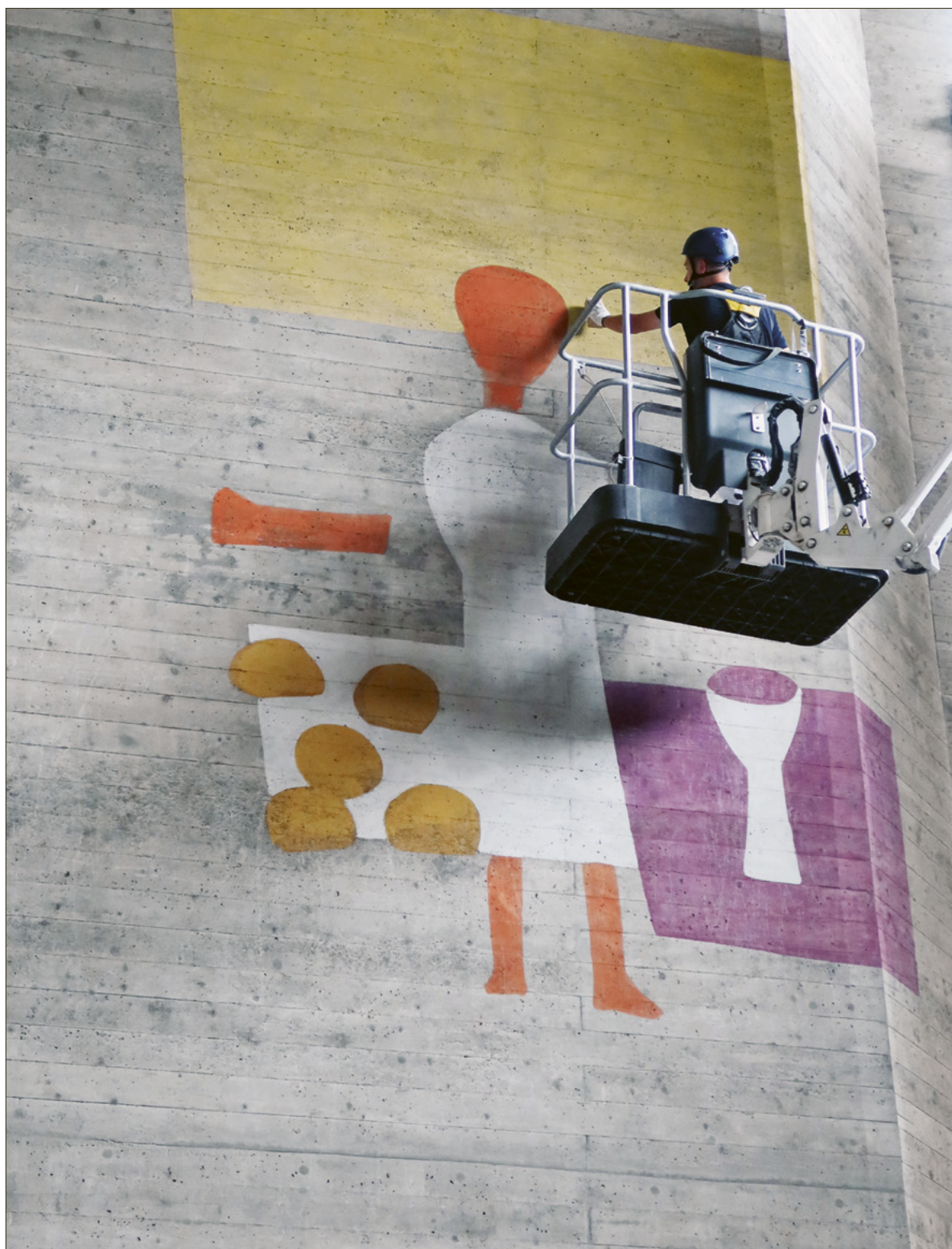
Reinigungsarbeiten an der Jesusdarstellung in der Kirche St. Michael. Foto: Guido Ludin
