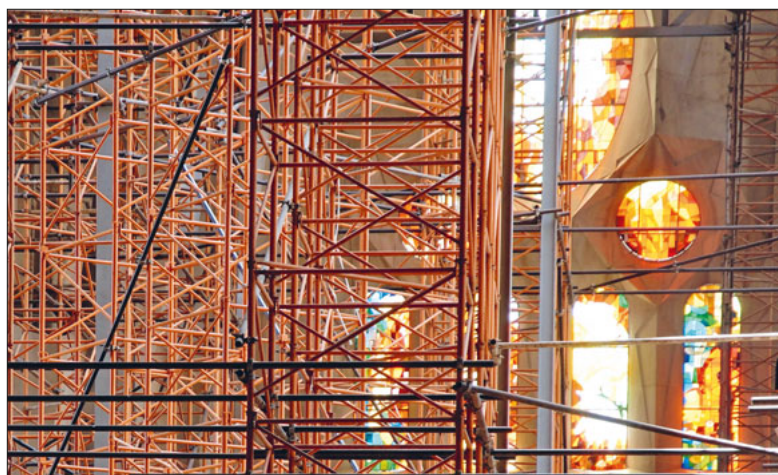
Baugerüst in der Kirche Sagrada Família in Barcelona. Foto: Alamy
