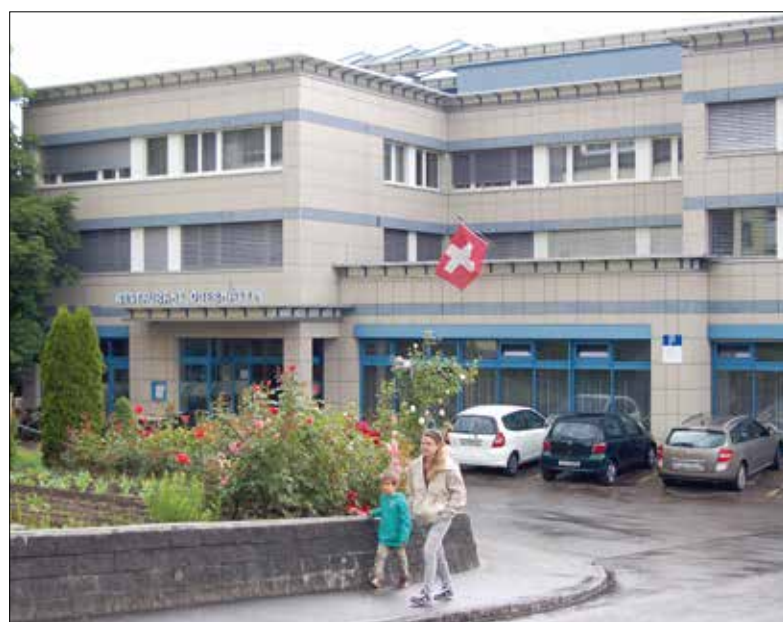
Verzögerungen bei der Sanierung des Hauses Obermättli und Abklärungen zum künftigen Betrieb des Restaurants beeinflussen die Rechnung. Bild: pg
